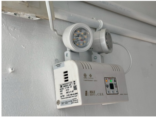
ภาพที่ 2-22 ไฟส่องสว่างฉุกเฉิน
